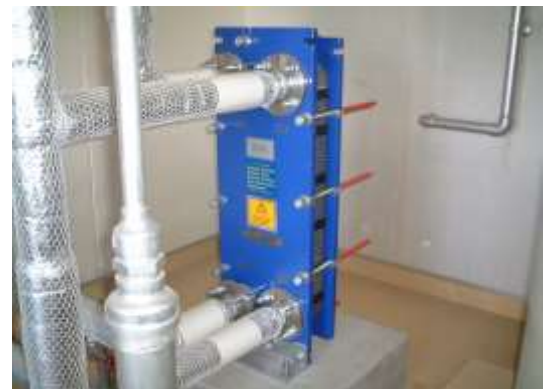
図 2.5.2 プレート式熱交換器の例
