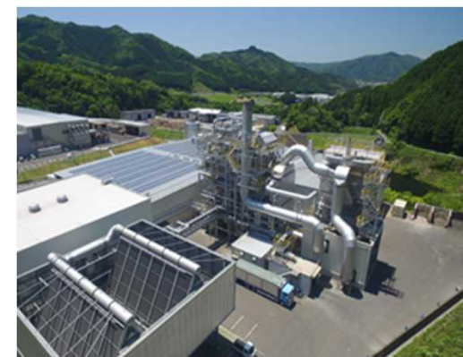
バイオマス発電施設（真庭市）
