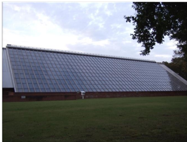
プール加熱(冷暖房給湯)
