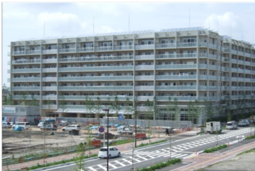
住棟セントラル暖房給湯システム
