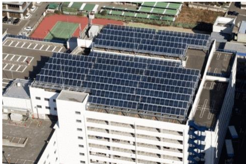
温浴施設における利用例(愛媛県) 給湯利用(901m 2 )
