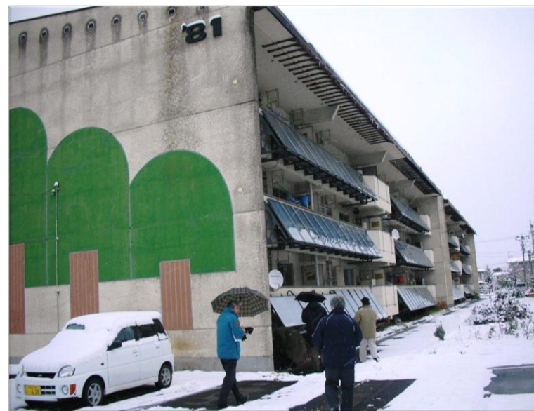
バルコニー設置給湯システム
